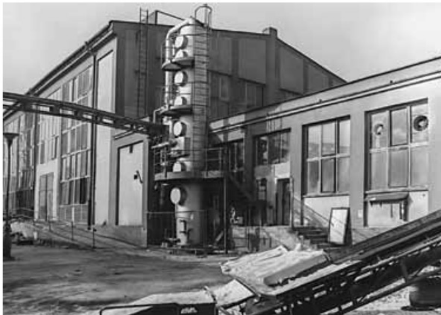
^Hutní hala po rekonstrukci, 70. léta.
