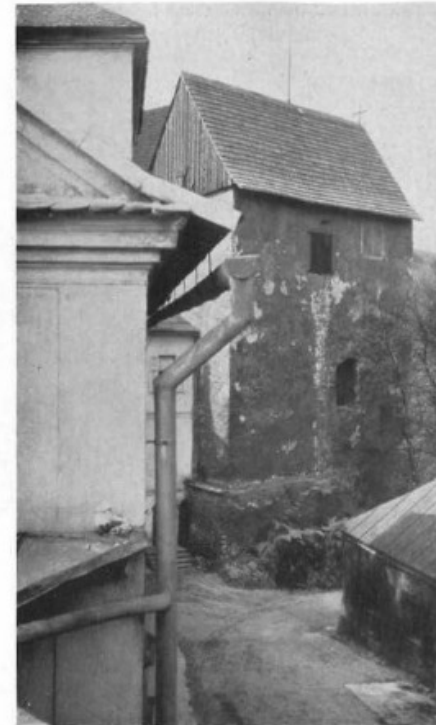
Abb. 204. Pöschau. Burghof und Kapellenturm. Aufnahme von der Plattform des abgetragenen Bergfriedes aus.
