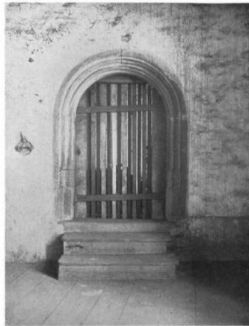
Abb. 229. Petschau, Oberburg: Rundbogenportal am Eingang des Wohnturmes.
