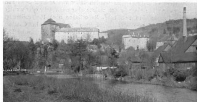
Abb. 200. Pöchlarn. Die von dem Umbauprojekt des J. 1870 verschont gebliebene Burgfront.
