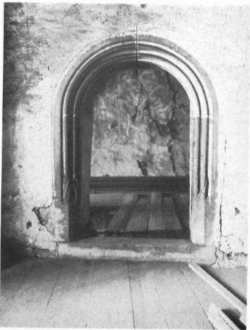
Abb. 228. Petschau, Oberburg: Rundbogenportal zwischen Saalraum und Schloßkapelle.
