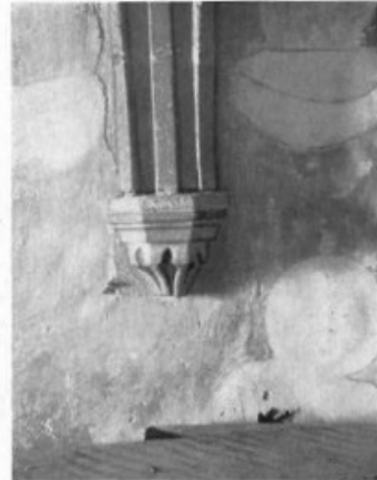
Abb. 206. Petschau, Schloßkapelle: Gesiertes Gewölkkonsole an der Längswand.
