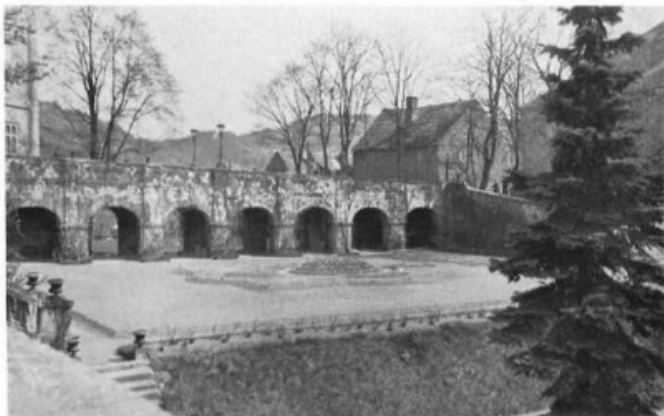
Abb. 247. Petschau. Schloßbrücke vor dem Neuschloß.
