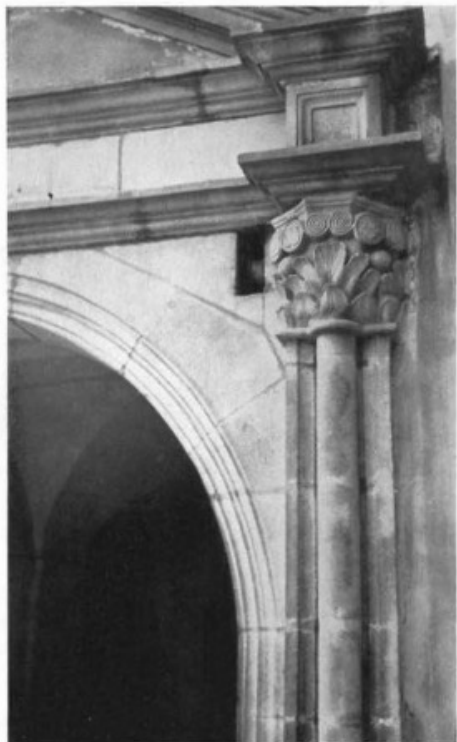
Abb. 245. Petschau. Neuschloß: Kapitäl aus der Architektur des Brückentores am Neuschloß.
