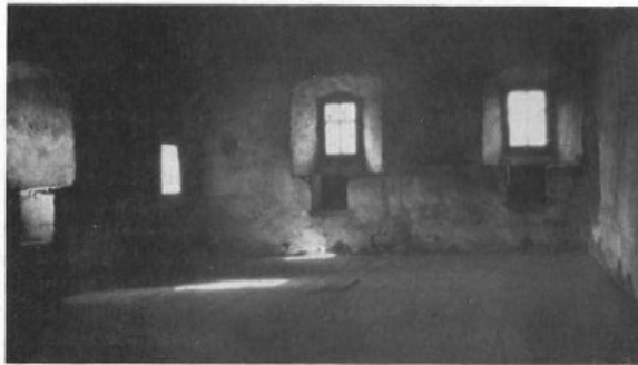
Abb. 233. Petschau. Oberburg: Fenster mit Wandlänken im vierten Stockwerk des Wohnturmes
