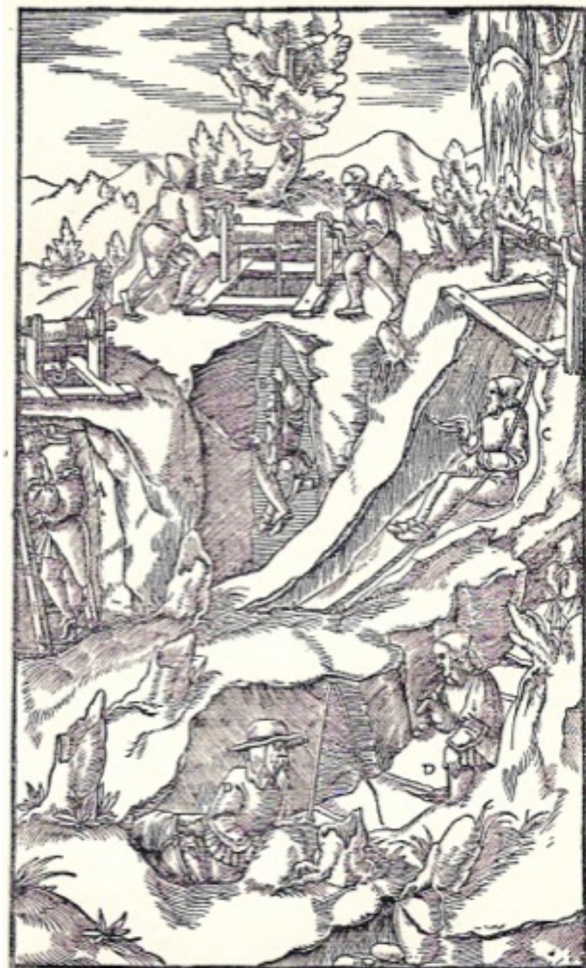
Po žebříku do socht sestupující A. Na dřevěném valochu sedící B. Na kůži sedící C. Sestupující po schodech do skály vytesaných D.
